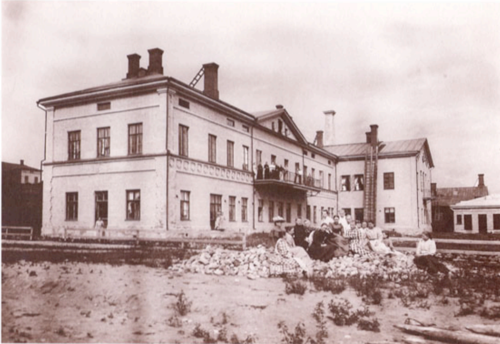
Kuva 1. Fredrika Wetterhoffin Työkoulun rakennus Hämeenlinnassa Palokunnankadun varrella vuonna 1893, muutama vuosi sen jälkeen kun Fredrika Wetterhoff oli hankkinut rakennuksen koulun käyttöön.
